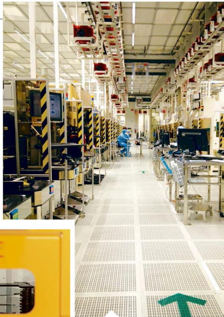
Salle blanche de l'usine Crolles 2 avec son système de convoyage automatique au plafond.
