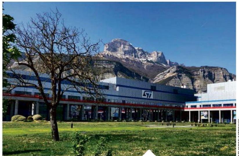
Vue générale du site de STMicroelectronics à Crolles.
