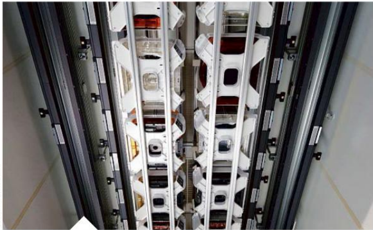
Rail au plafond pour les véhicules de convoyage automatique des produits.
